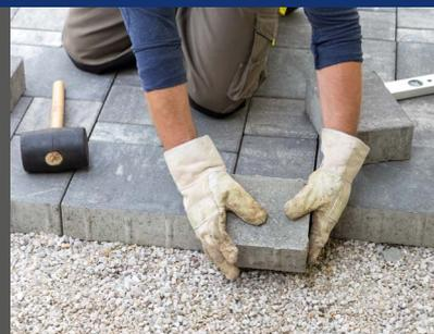
1. **Pflastersteindecken** sind einzufassen, um ein Verschieben des Betonsteinpflasters zu verhindern. **Randeinfassungen** sind gemäß den Richtlinien und Vorschriften für den Straßenbau (RVS) auszubilden. **Betonrandsteine** in Pflasterdrainbeton versetzen und Rückenstütze ausbilden. Alternativ können Randeinfassungen auf eine erhärtete Betonunterlage im Drainmörtelbett verlegt werden. In Bereichen ohne Belastung können auch nagelbare Kunststoff- oder Metallrandschienen verwendet werden.
