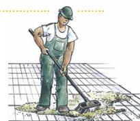
5. **Fläche sauber abkehren und mit einer geeigneten Rüttelplatte mehrmals längs- und quer abrütteln.** Immer an einer Außenseite der Fläche und am tiefsten Punkt beginnen. Zum Schutz der Steinoberfläche vor Kratzspuren und Kantenabplatzungen einen Rüttler mit Kunststoff- oder Gummiplatte verwenden. Nochmals mit Fugensand ein- und anschließend abkehren. **Die gepflasterte Fläche ist nach dem Rütteln sofort benutz- und befahrbar.**
